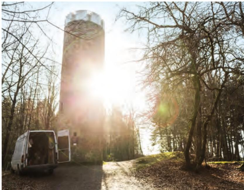
Nachbarn steht der Bismarckturm. Er wurde im Jahr 1911 erbaut. Parallel zu der obigen Maßnahme sollen hier einzelne Bruchsteine eingepasst, Risse neu verfugt und zum Schutz des Fundaments eine stilgerechte Pflasterung verlegt werden. Um die Arbeiten sicher durchführen zu können, ist eine
